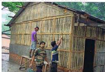
Bau neuer Klassenzimmer
